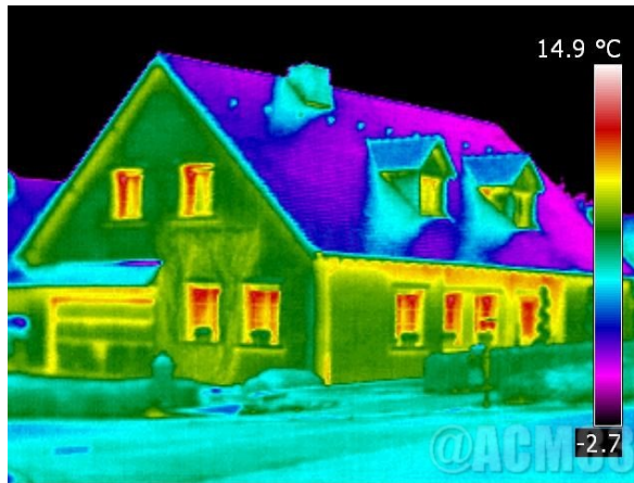
Provera toplotne izolacija
